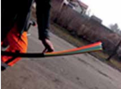
1. Zdjęcie płaszcza zewnętrznego na odcinku \pm 50 cm.
