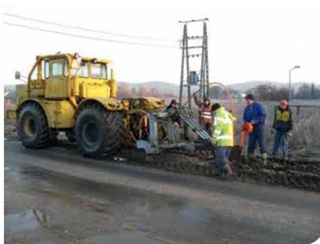
Fot. 8. Instalacja pługoukładaczem wiązki Novonet DB 5/10 wzdłuż drogi gminnej.
