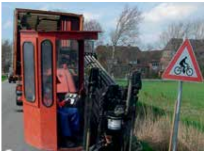
4. Wykonanie otworu wiertnicą.
