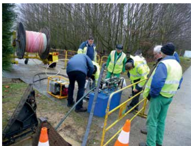
Fot. 7. Wiazka Novospeed 3*10x1,0*UD przygotowana do wdmuchiwania do rurociagu OPTO 32/2,9.
