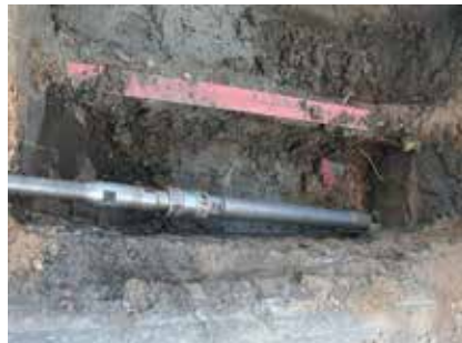
5. Łączenie segmentów wiertła.
