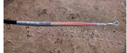
3. Montaż pończochy kablowej na płaszczu i na mikrorurach.
