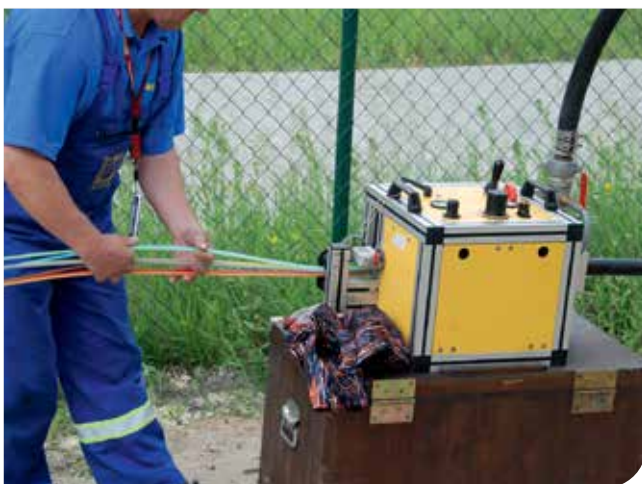
Fot. 5. Wdmuchiarka do mikrorur Przedsiębiorstwa WPRT, wdmuchująca siedem Novomicro 7 do OPTO 40 w Szczecinie.
