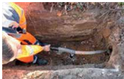
8. Połączenie wiązki z głowicą i zaciąganie powrotne, z uwzględnieniem maksymalnej siły rozciągającej wiązkę (patrz tabela na następnej stronie).
