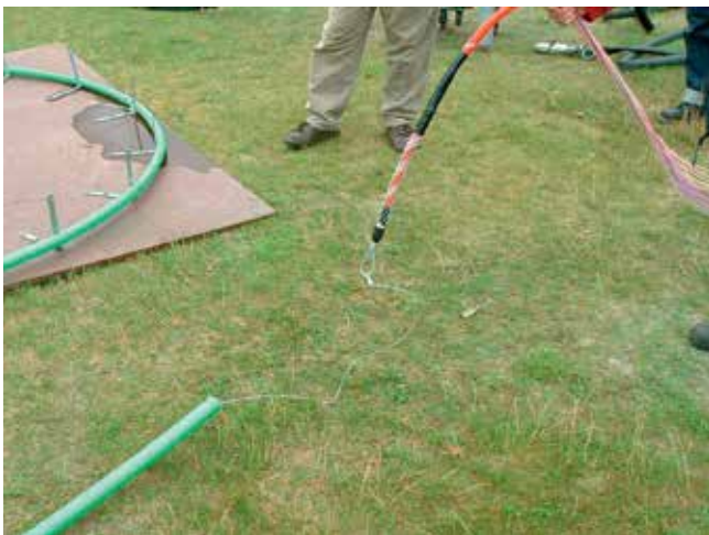
Fot. 1. Przygotowana do zaciągania wiązka 24 mikrorur Novomicro 4 do OPTO 40 na poligonie w Holandii.
