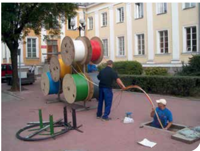
Fot. 2. Specjalna wiązka 8 mikrorur Novomicro – 3x10, 2x7, 3x5 zaciągana do rurociągu światłowodowego w Siedlcach.
