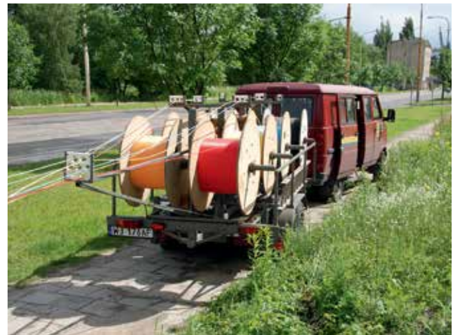
Fot. 6. Bateria siedmiu bębnow mikrorur Novomicro 7.
