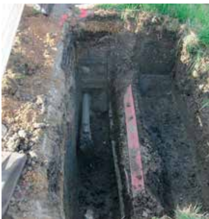
7. Odkryta głowica wiertła.
