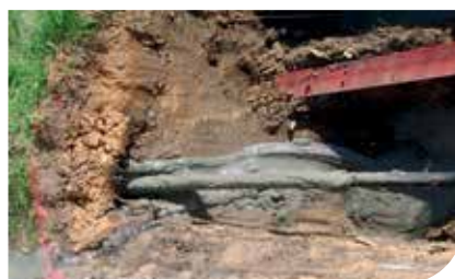
10. Instalacja zakończona sukcesem.
